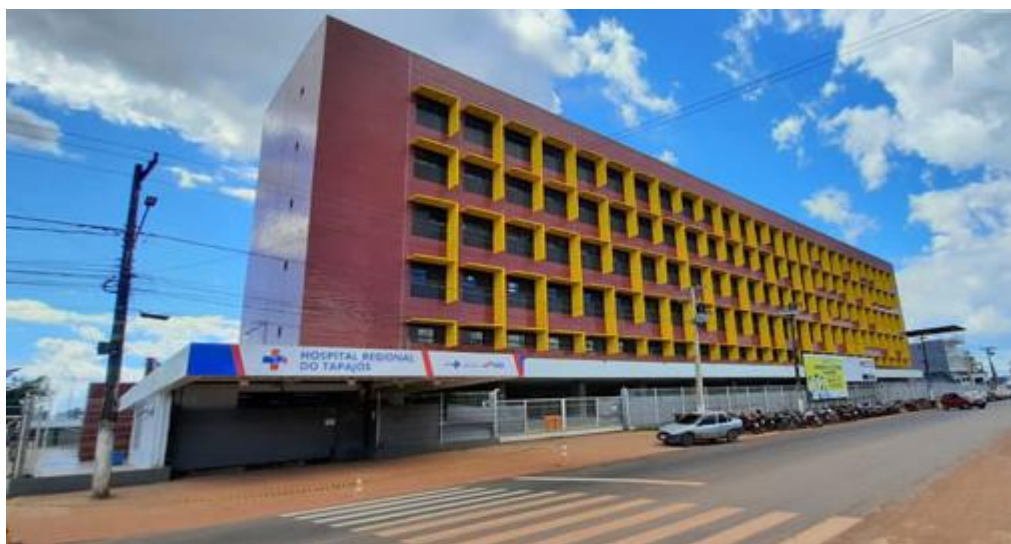
Figura 3 - Hospital Regional do Tapajós.
