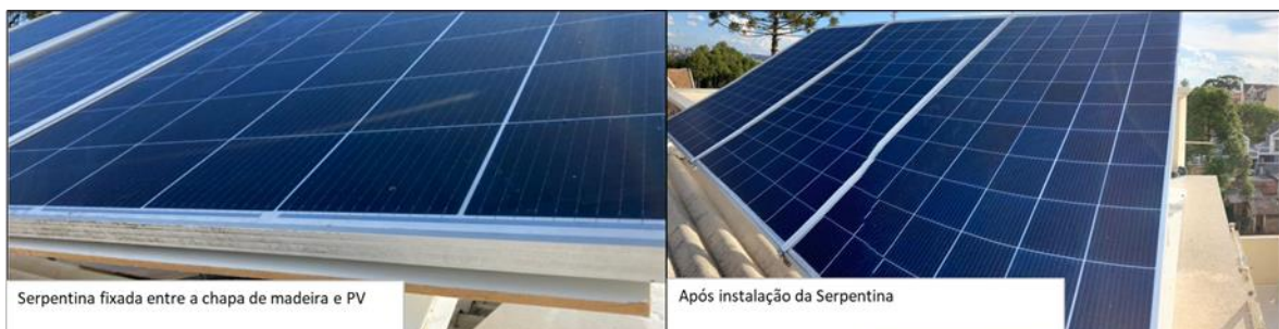
Figura 29 – Painel Solar após o acoplamento da serpentina.
