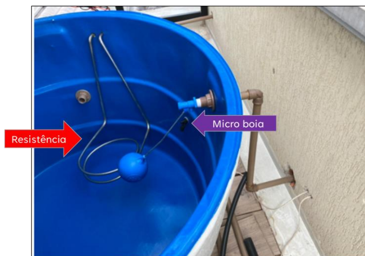
Figura 23 - Resistência e micro boia montada no CX1.
