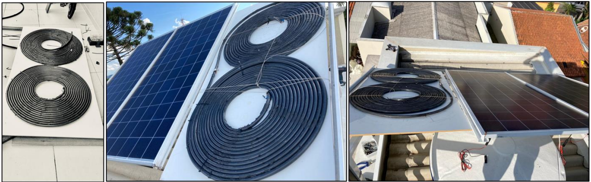
Figura 28 - Serpentina que foi instalada abaixo do PV 1.
