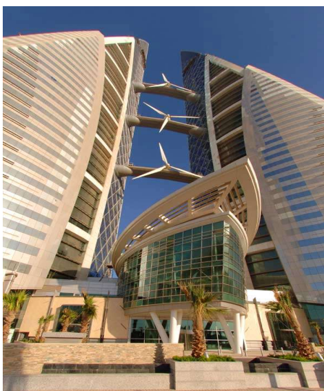
Figura 4: Imagem panorâmica do World Trade Center no Barém no qual apresenta o design que favorece a produção de energia eólica por 3 aerogeradores externos à estrutura do edifício.
