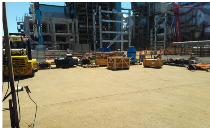
Figura 3 – Manutenção – parada de máquinas
