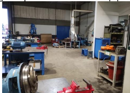
Figura 5 – Reforma da oficina mecânica e reorganização de ferramentas e equipamentos
