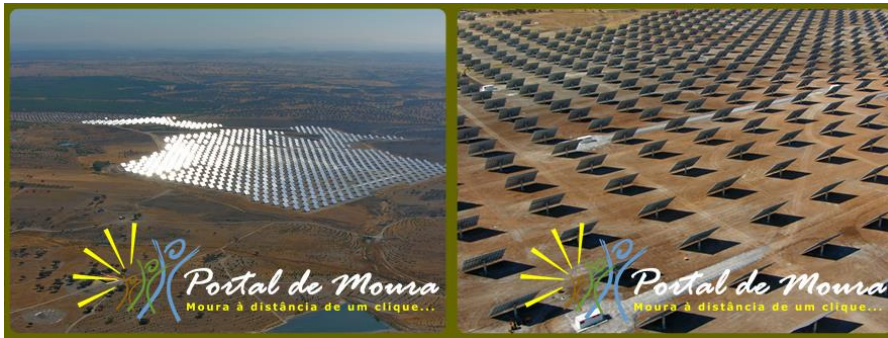
Figura 3: Estação de captação de energia solar, Amareleja – Portugal. Fonte: PORTAL DE MOURA, 2018.
