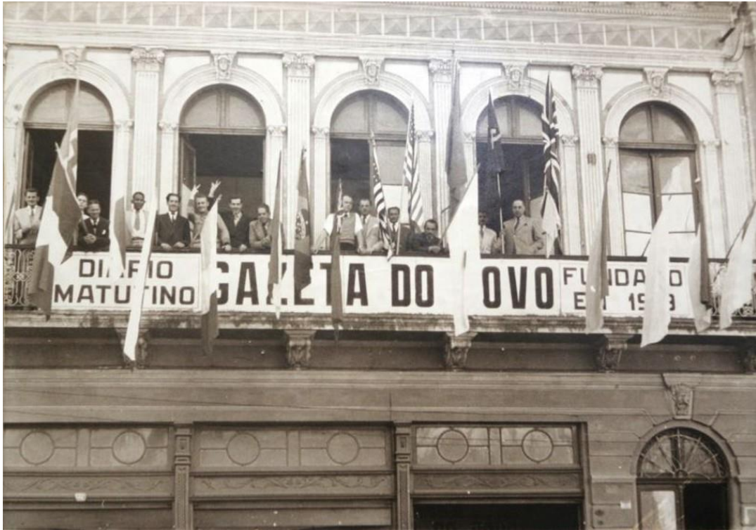
FIGURA 2 – FACHADA GAZETA DO POVO NA FUNDAÇÃO EM 1919
