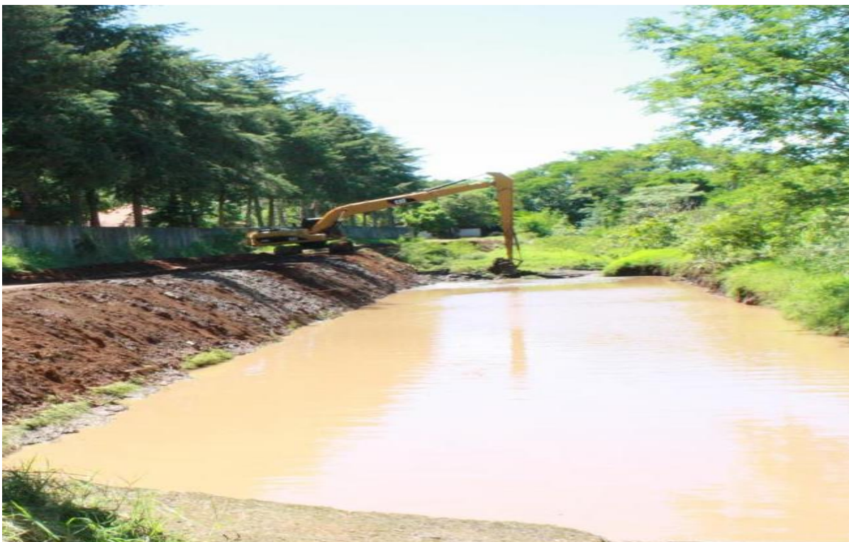
Anexo B: Dragagem do Córrego Urutago (2013). Fonte: Site Prefeitura Municipal.
